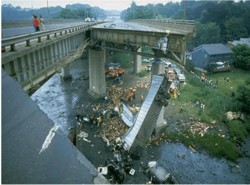
图 1 垮塌的迈安那斯河桥
